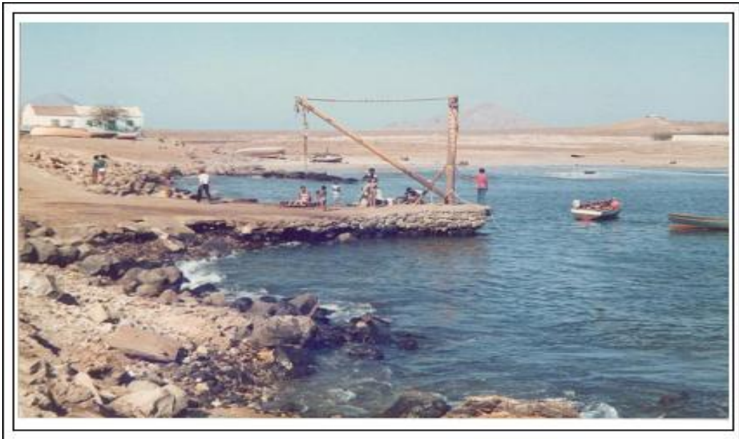
Antigo cais da Palmeira
