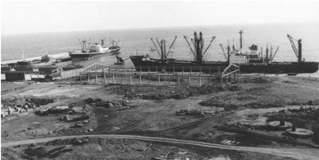
Construção do Novo Porto da Praia
